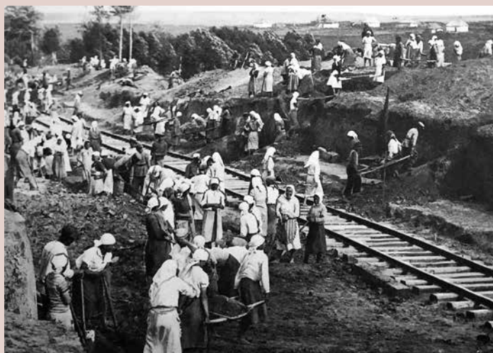
Строительство железной дороги Старый Оскол — Ржава. Июнь 1943 г. Государственный архив Курской области
